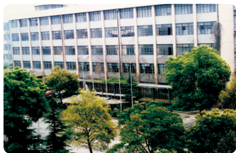
上海水产大学渔工大楼（摄于20世纪90年代）
